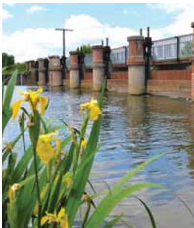
Barrage de la Steinsau à Erstein - © Stadler
