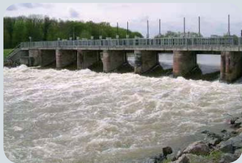
Digue des hautes eaux du Rhin au cœur du Polder d'Erstein, réalisée en 1810.
